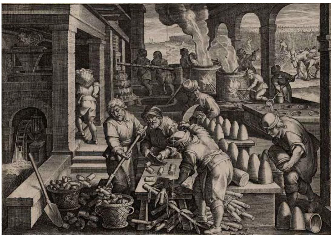
Gravat que representa el procés d'elaboració del sucre en un enginy
