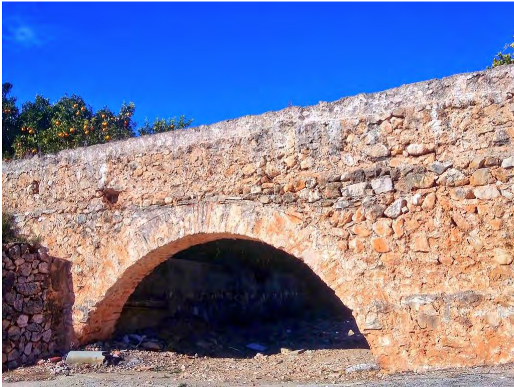
Aqüeducte sobre el barranc del Garrofer
